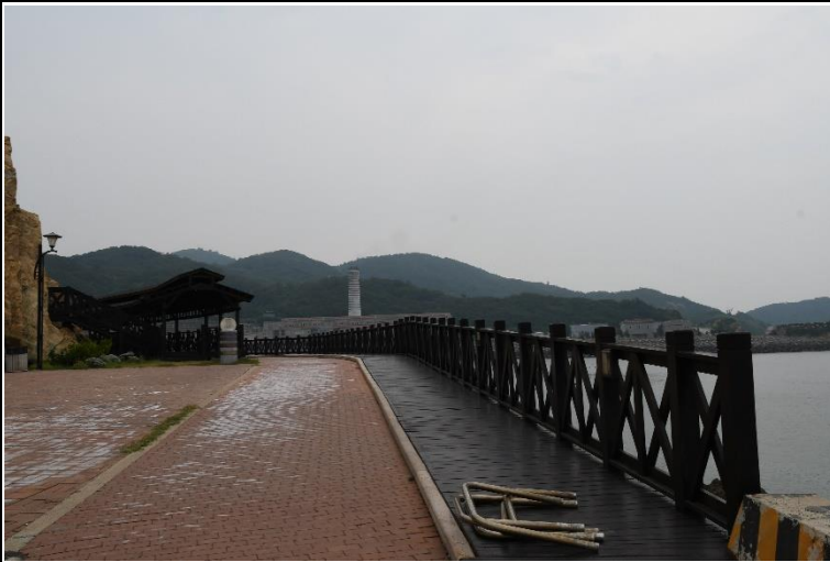
□■海岸及護坡照片(西側海堤)
