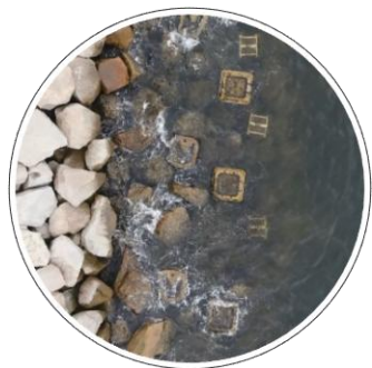
施作工項 1 增加天然塊石或 生態組件，增加 多孔隙生態棲地
