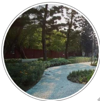
施作工項 2 硬質水泥鋪面改為透水性鋪面
