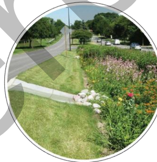
設置兼具生態、滯洪 複合功能的雨水花園， 增加環境韌性，並有 效縫合生態廊道與在 地關注物種棲地
