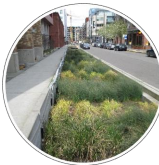
施作工項 2 交通柱改為綠化隔 離帶，提升景觀性， 並可淨化空氣，降 低噪音
