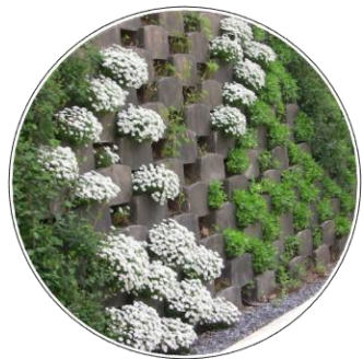
水泥壁面改造為 階梯生態棲地
