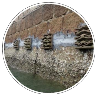
施作工項 1 於沿岸壁面設置 生態組件，打造 多孔隙生物棲地
