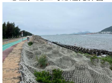
親水平台：以天然塊石取代消波塊，增加生態棲地，打造為水環境教育平台
