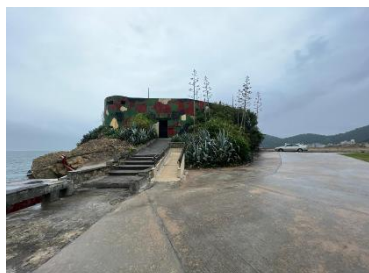
勝利堡周邊：混凝土地坪，缺乏透水性，臨海岸為高敏感區，施工時應避免影響
