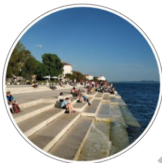
施作工項 2 使用馬祖花崗石 材料，設置潮汐 觀景階梯及環境 教育解說空間
