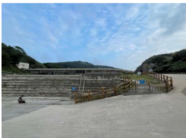
水庫前混凝土空地：以生態工法打造，增加生態棲地、滯洪功能
