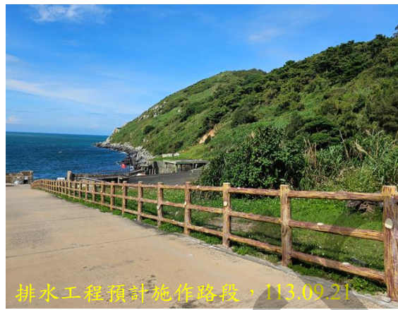
排水工程預計施作路段 2
