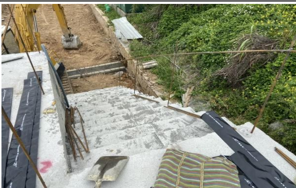
安全樓梯施作
