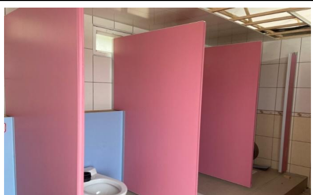
公廁內部整修
