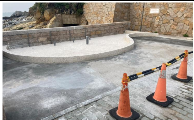
觀景平台施作
