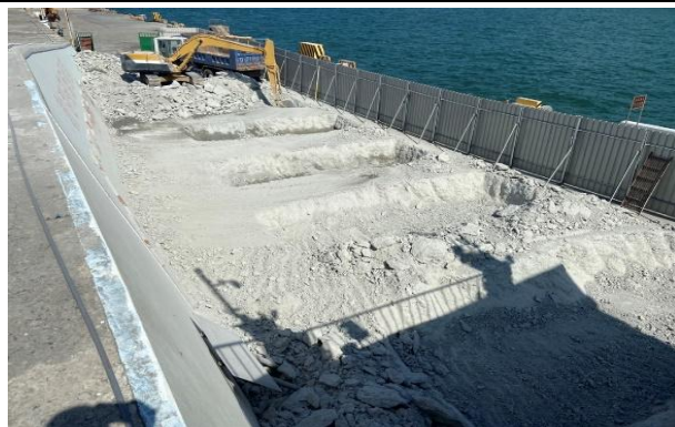
港區周邊道路施作
