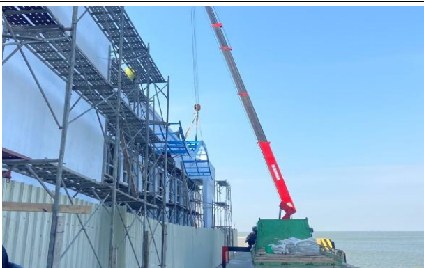
候船室外牆雨遮施作
