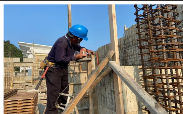
港區周邊施作
