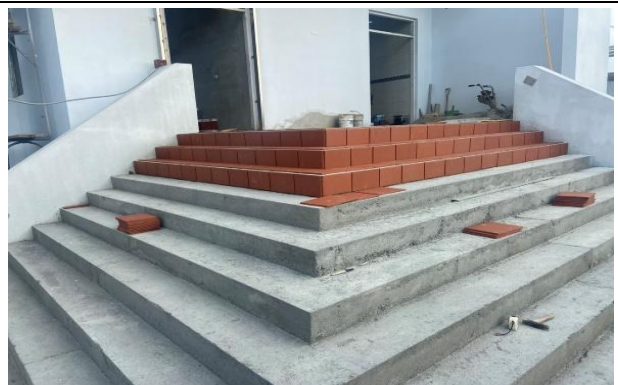
候船室外階梯施作
