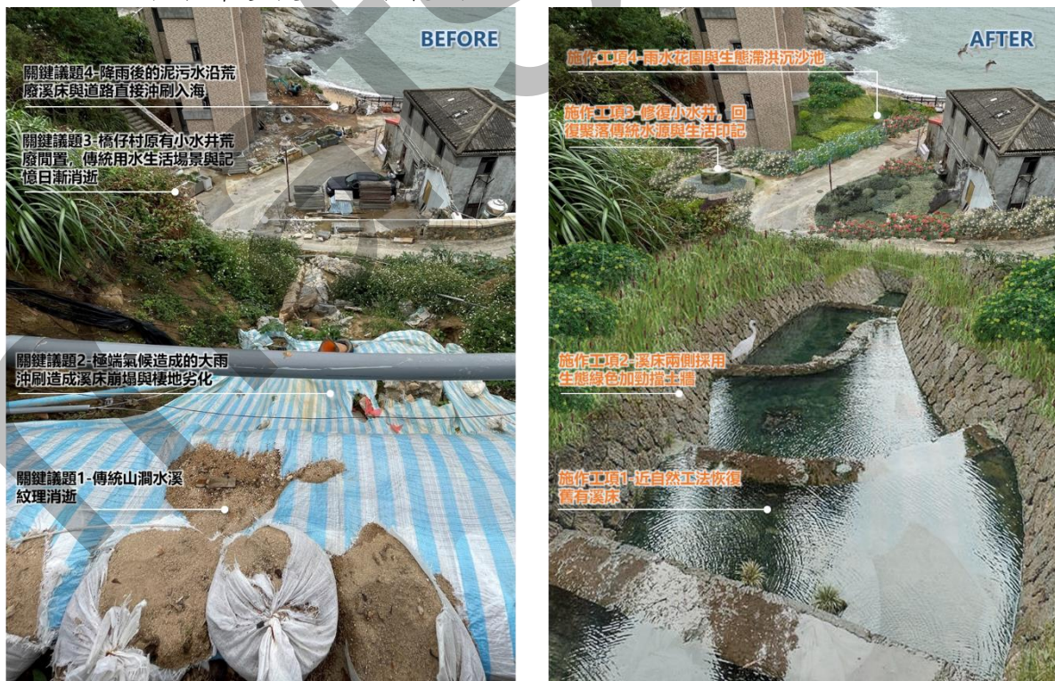
圖 4-5 阿南境小水井修復及低衝擊開發設施示意圖
