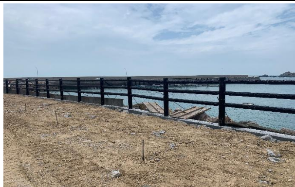
仿木欄杆施作
