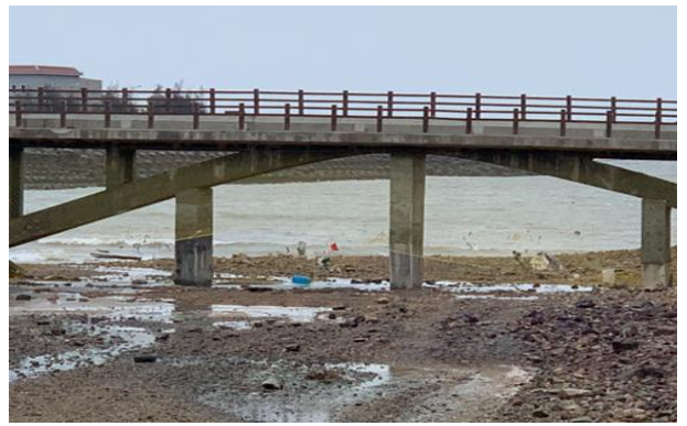
橋梁支撐柱完工
