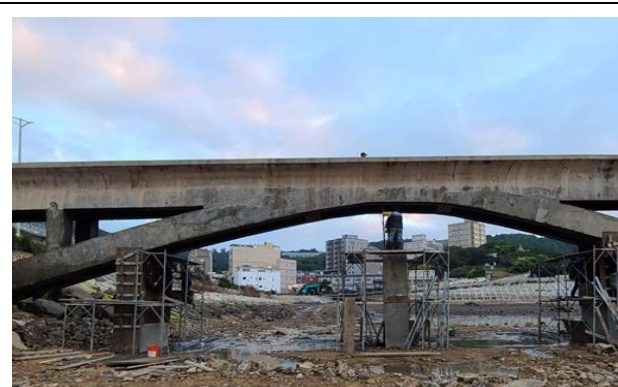
橋梁支撐柱施工
