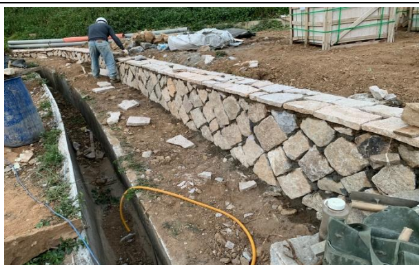
水路旁砌石施作
