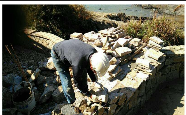
步道砌石施作
