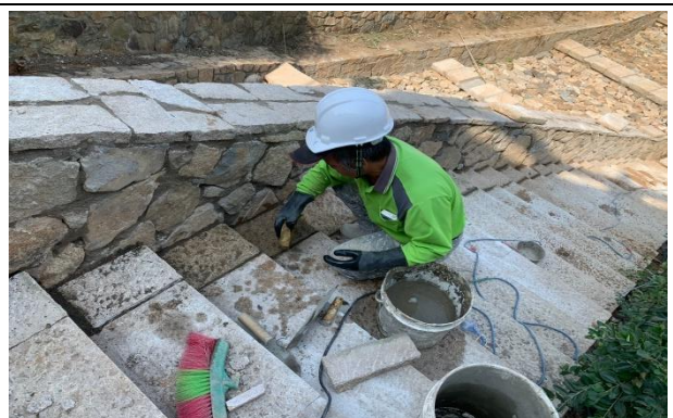
步道階梯施作
