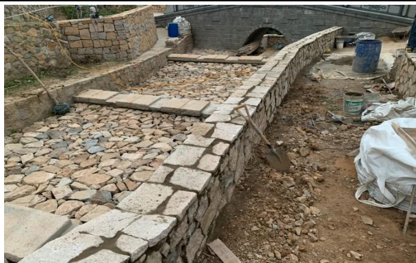
水路砌石施作
