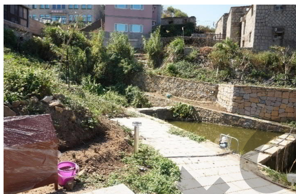
工程預定地現況-周圍多為人工建物
