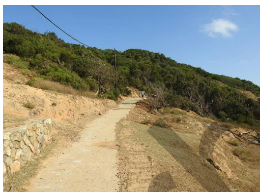
工程預定地現況- 大坵島東側迎風面步道，風大且乾燥，植被多為短莖草生地
