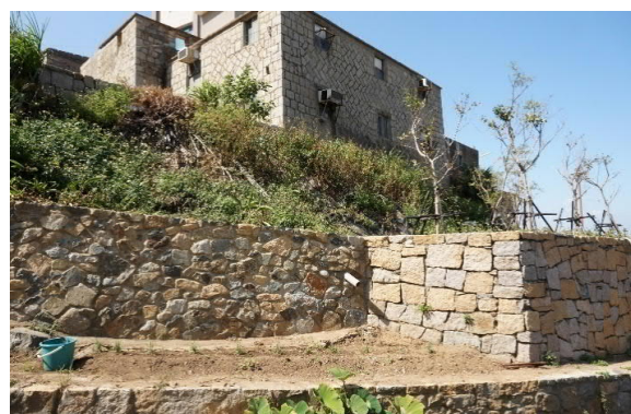
工程預定地現況-排水管直接排入水池
