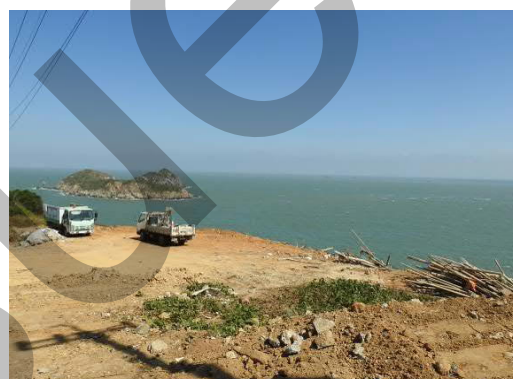
工程預定地現況-多為裸地
