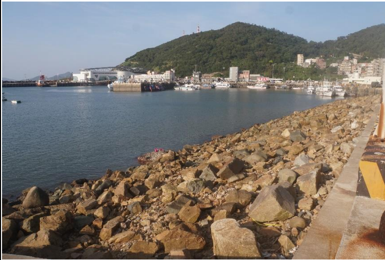
□■棲地照片、□■海岸及護坡照片(花崗岩拋石護岸)
