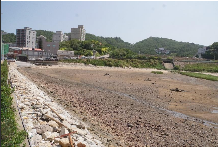
□■棲地照片、□■海岸及護坡照片(清水廠前方之花崗岩拋石護岸及清水濕地之環境及棲地照片)
