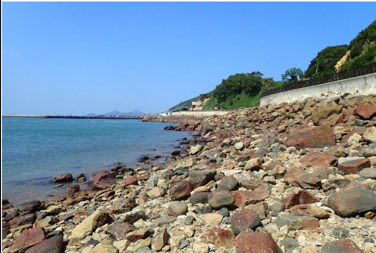
□■海岸及護坡照片(中間段護岸，包括花崗岩拋石護岸及自然岩礁)
