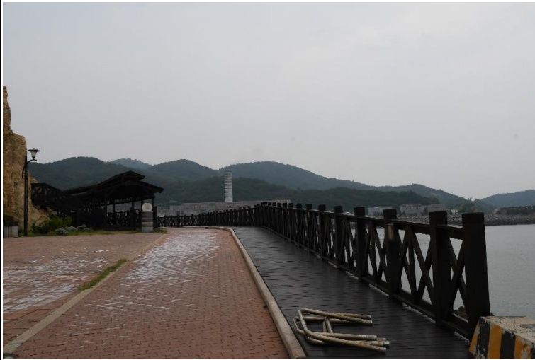
□■海岸及護坡照片(西側海堤)
