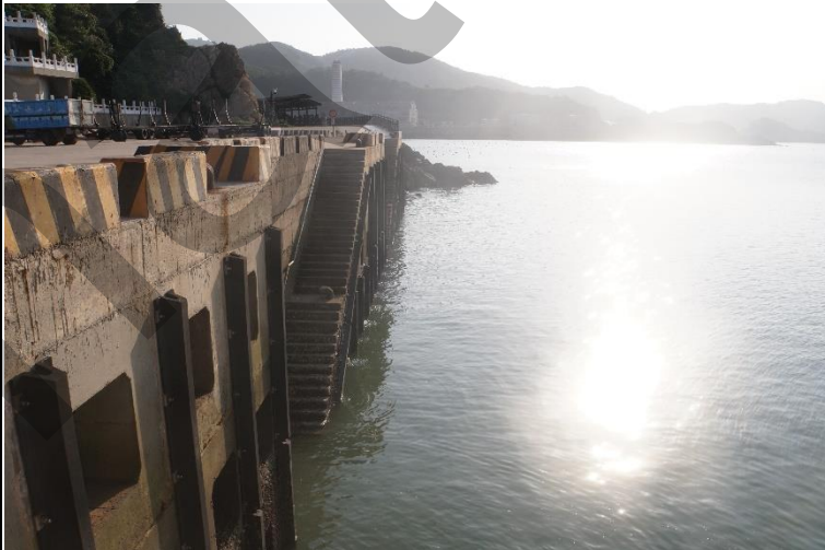
□■棲地照片(海牆)、□■海岸及護坡照片(垂直水泥海牆)
