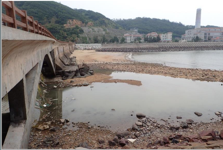
□■海岸及護坡照片(清水濕地其他分區海岸照及橋梁堤防及珠山電廠側之護岸)
