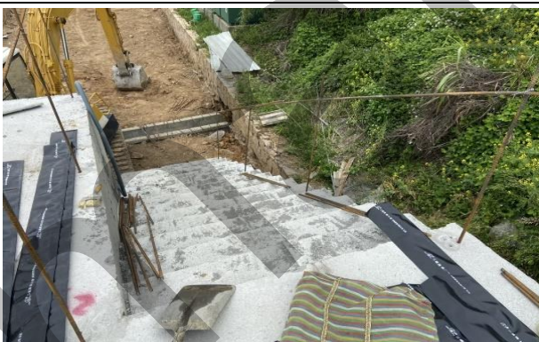
安全樓梯施作
