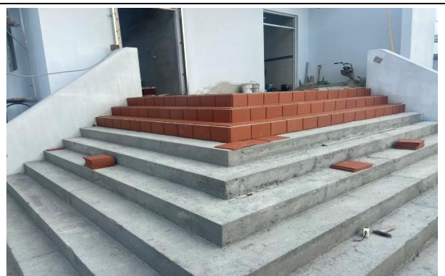
候船室外階梯施作
