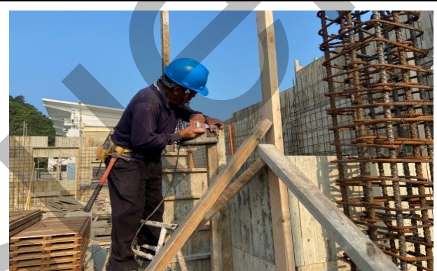
港區周邊施作
