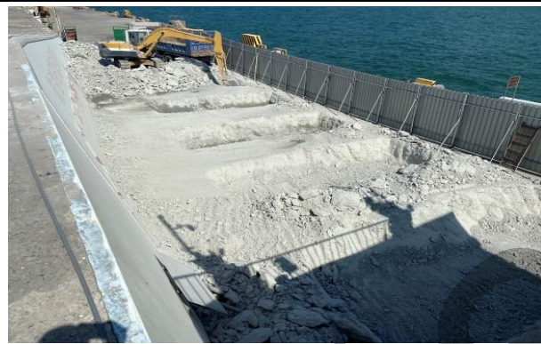
港區周邊道路施作
