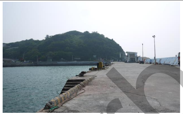
青帆港周邊道路現況
