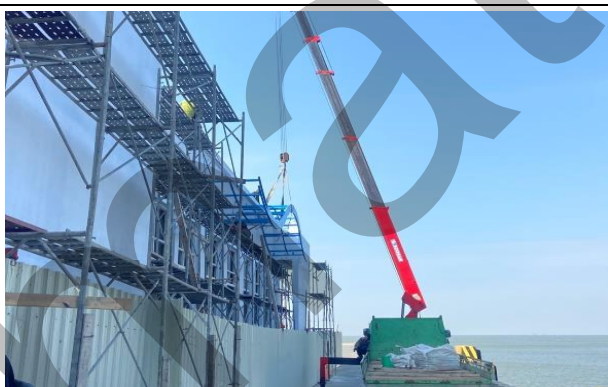
候船室外牆雨遮施作
