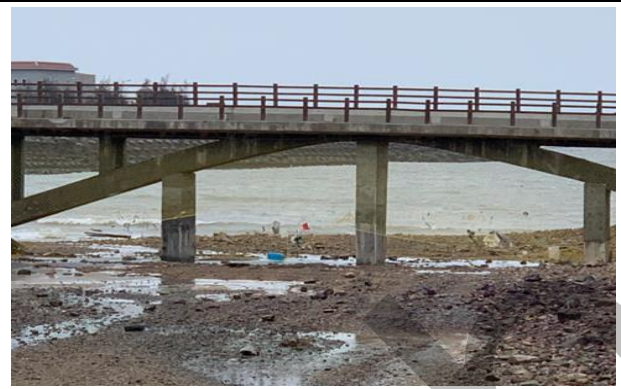
橋梁支撐柱完工
