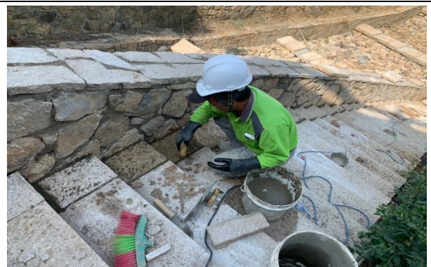
步道階梯施作
