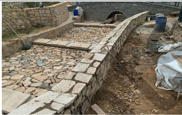
水路砌石施作
