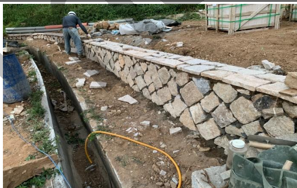
水路旁砌石施作
