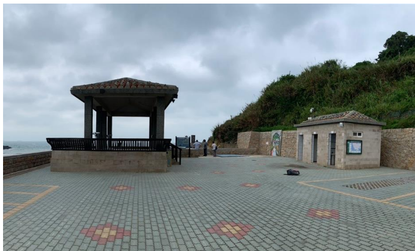
圖 2 西莒坤坵景觀涼亭周邊現況圖
