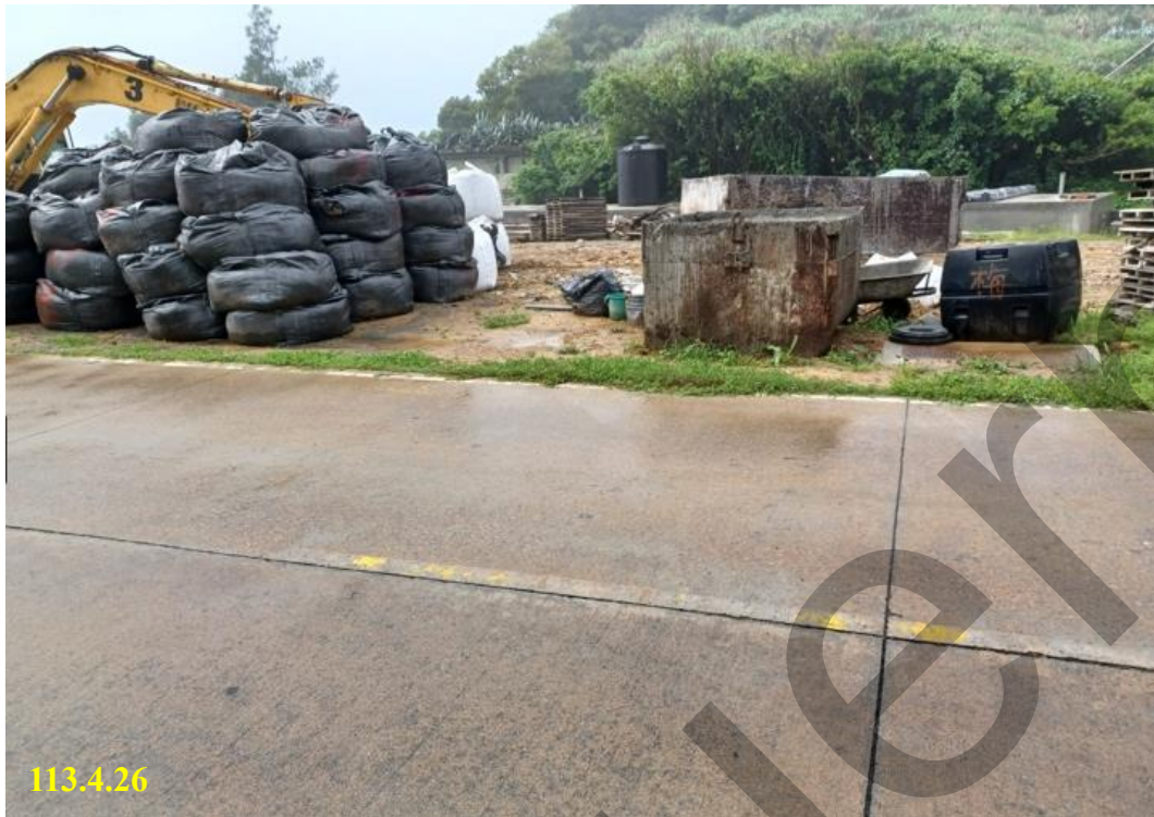
▲ 施工材料集中堆置 1
