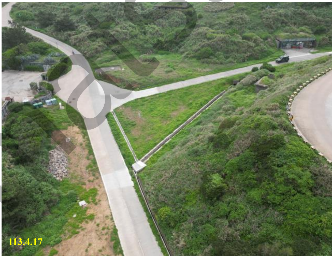
▲ 另案工程辦理之排水設施改善
