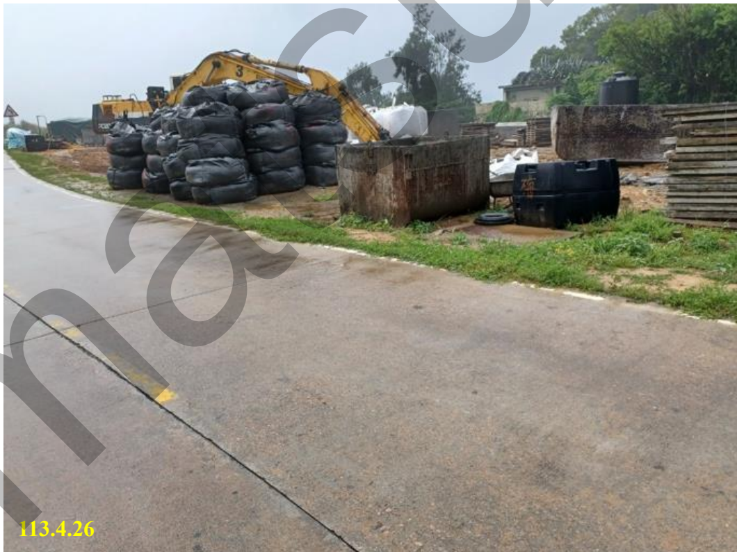
▲ 施工材料集中堆置 2
