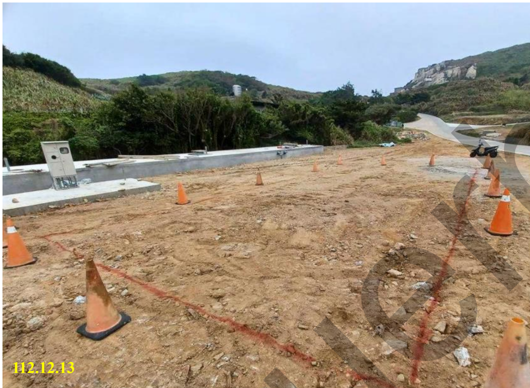
▲ 放樣施工範圍限制於機關合併式淨化槽工程與道路間之裸露地範圍
