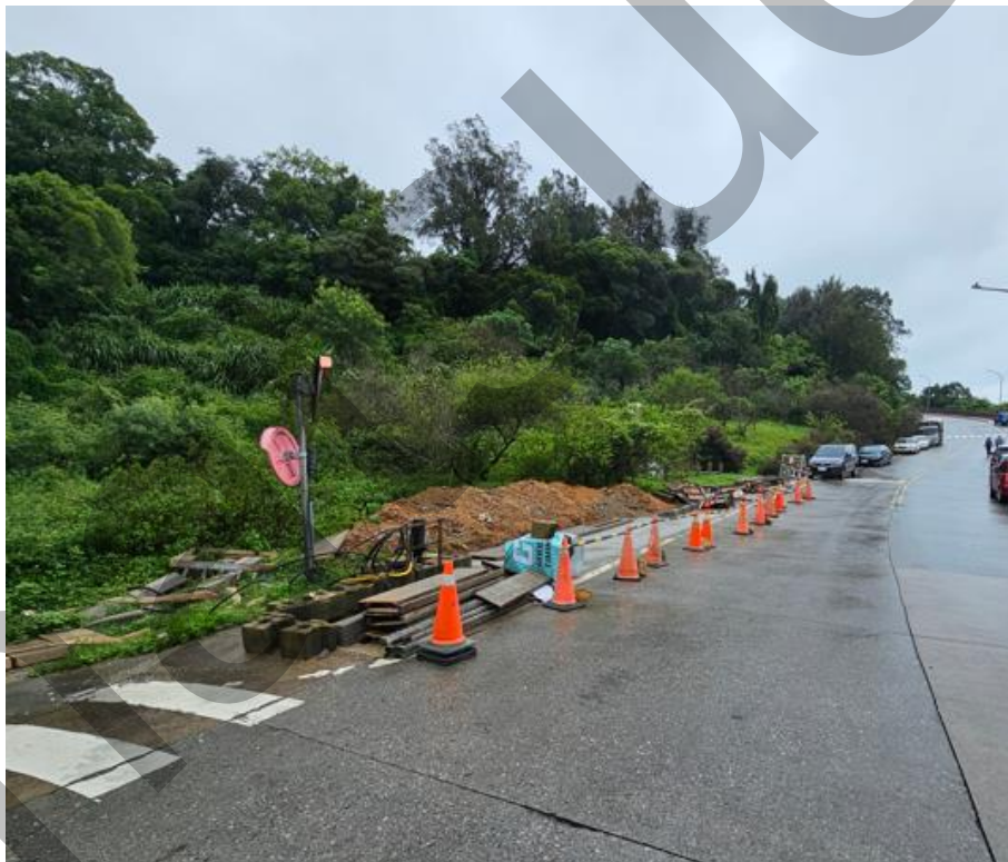
▲ 施工期間之廢棄物及土方集中堆置於既有空地
