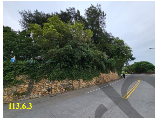
沉沙池(二)預定施作區域(既有道路側)
