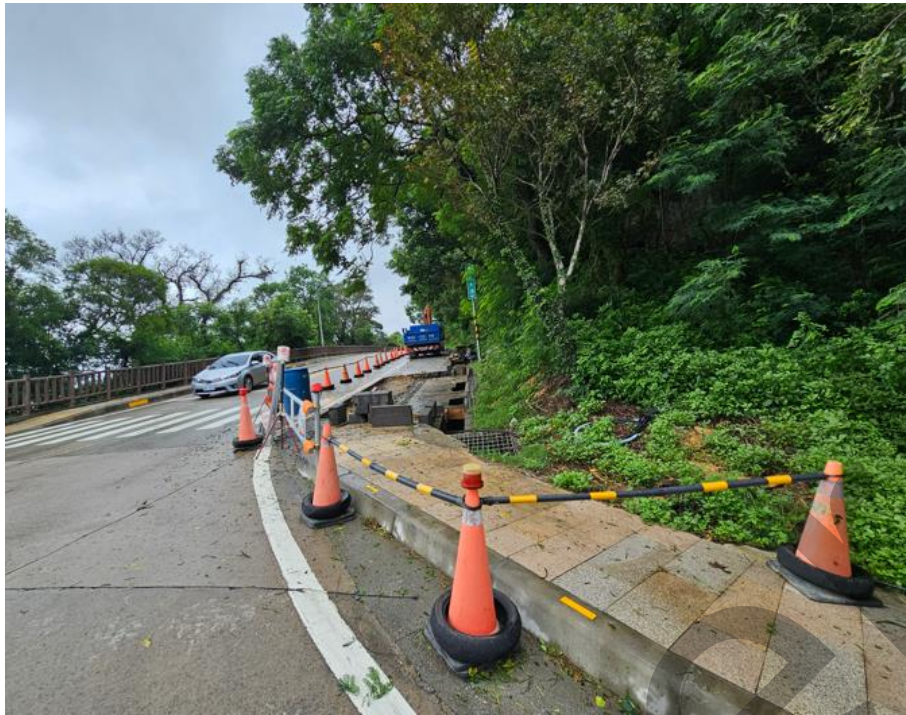
▲ 施工便道優先使用既有道路
