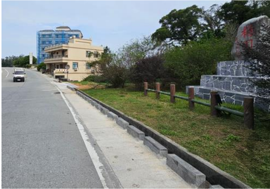
▲ 工地復原增加植栽綠化
