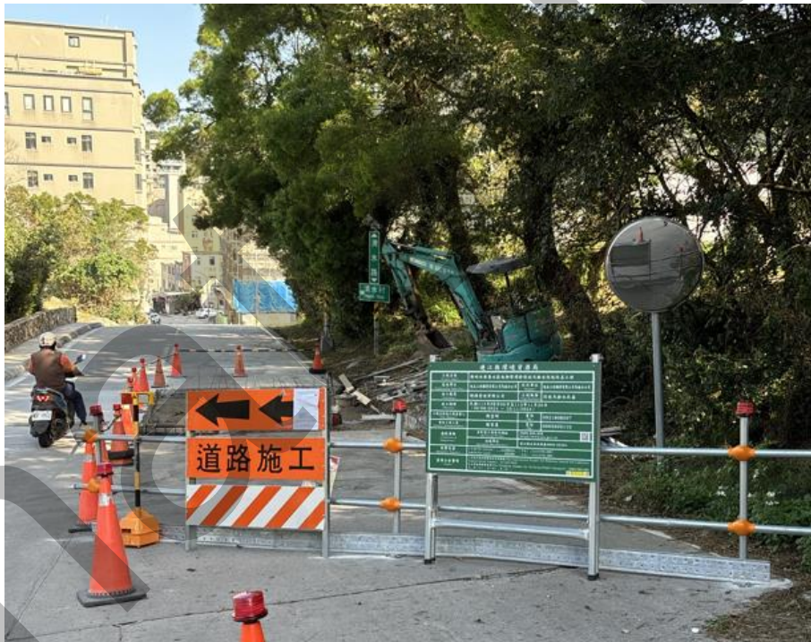
▲ 工程施作期間(地表開挖)採取適當防護及水保措施
