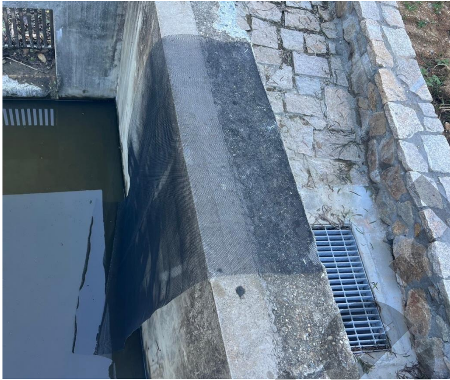
▲ 沉砂池新設攀爬網
