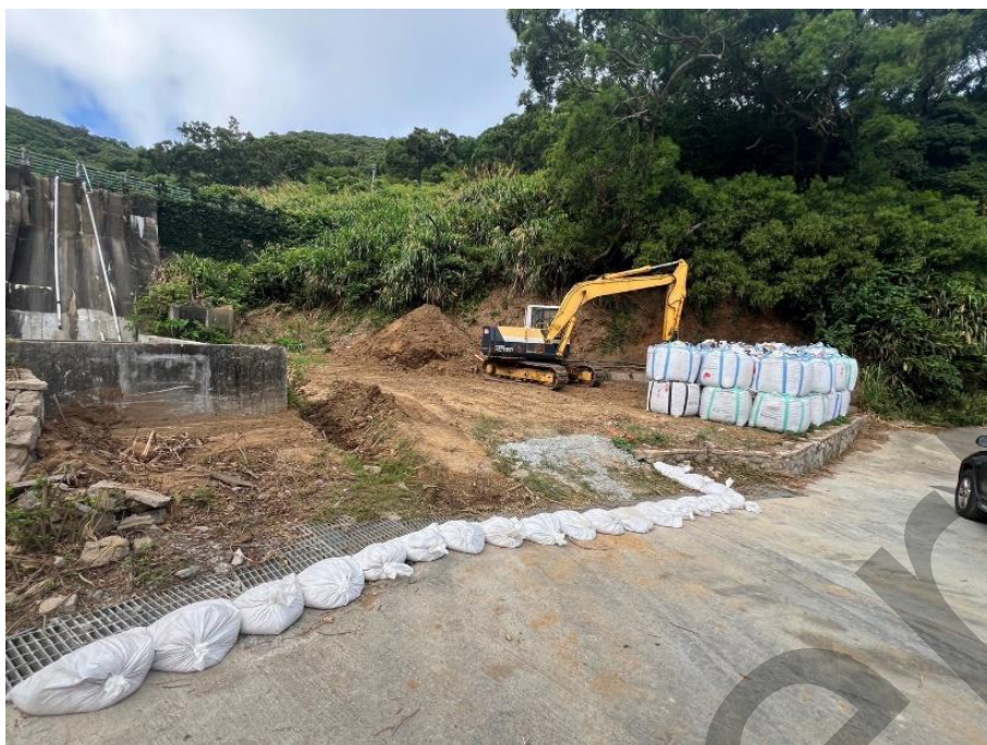
▲ 物料集中堆置並施加防護措施
