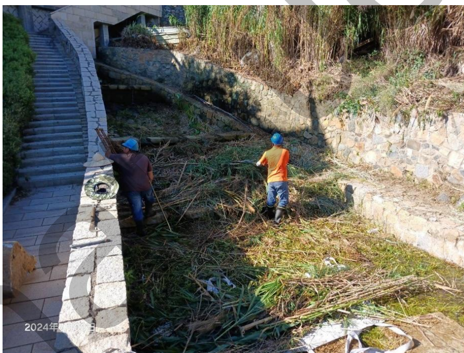
▲ 優先使用既有道路，不另開闢新施工便道
