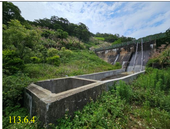
橋仔水庫下方沉砂池
