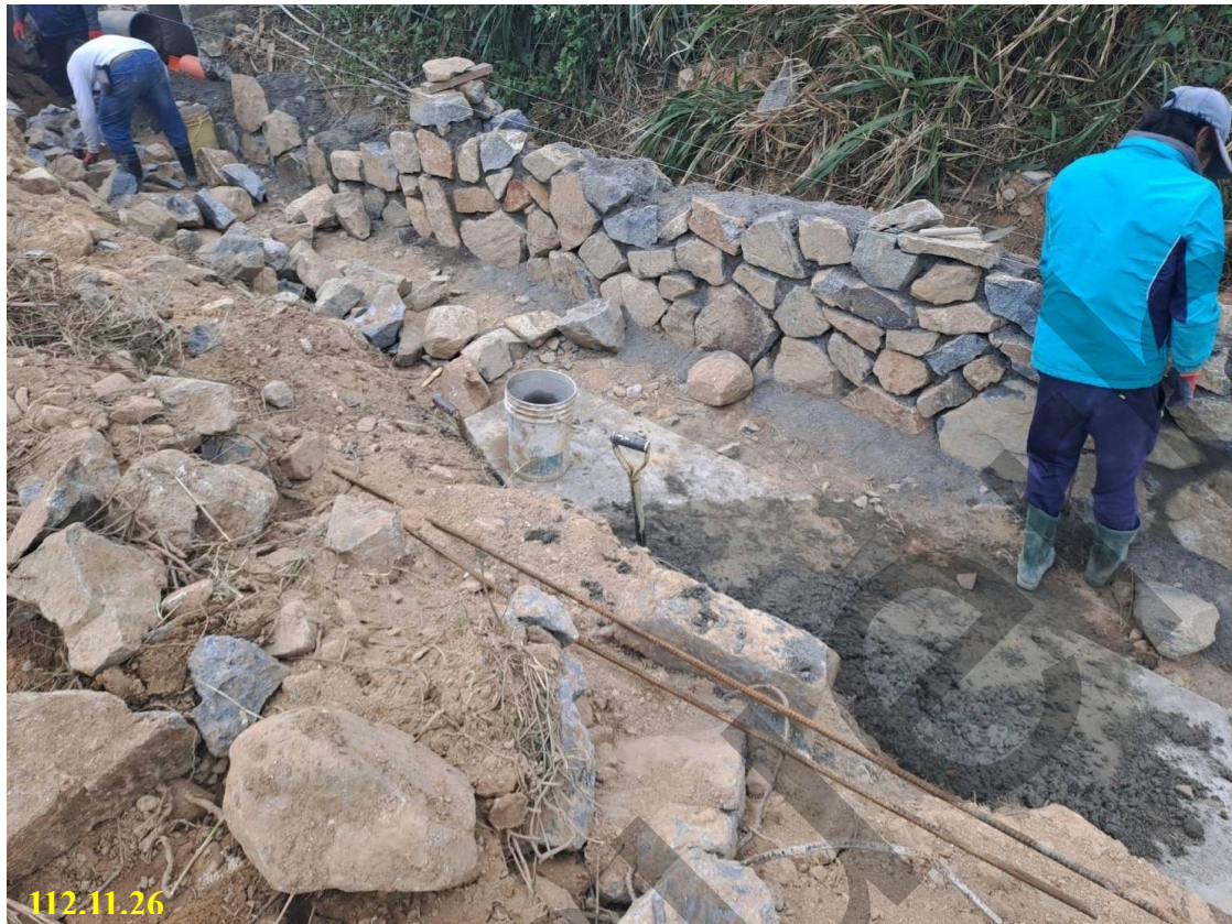
▲ 部分排水溝修復採用砌石坡面，增加生物棲地空間
