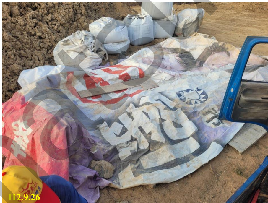
▲ 施工期間之廢棄物，集中加蓋處理，並運離現場
