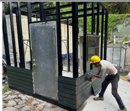
中正門 MSL 場址機房施工
