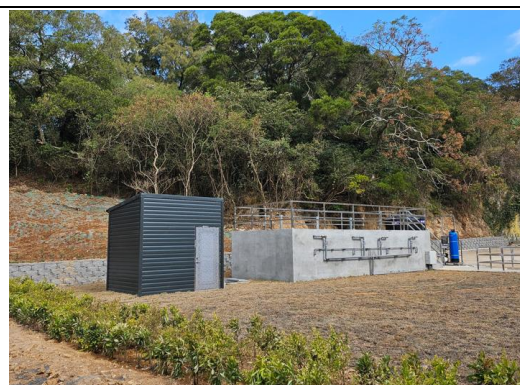
水質淨化設施完工
