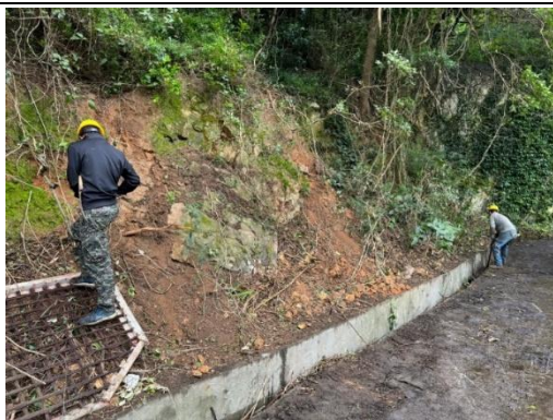
水土保持設施施工
