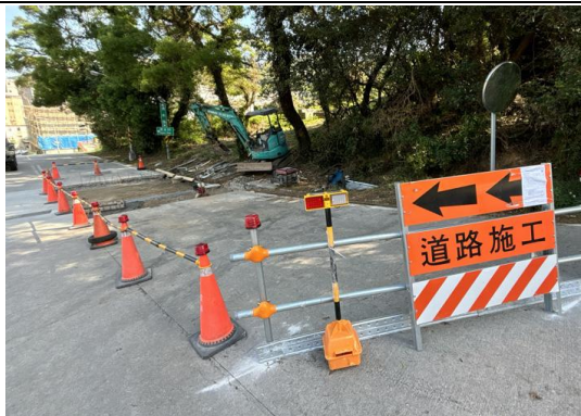
橫向截水溝施工
