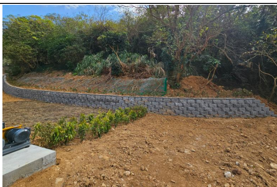
水土保持設施完工
