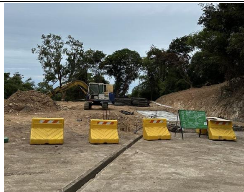
水質淨化設施施工
