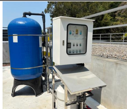
儲水沃上壩 MSL 場址砂濾系統完工
