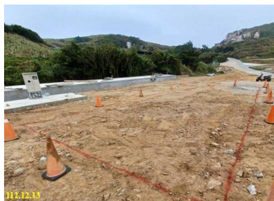
施工範圍限制於淨化槽與道路間
