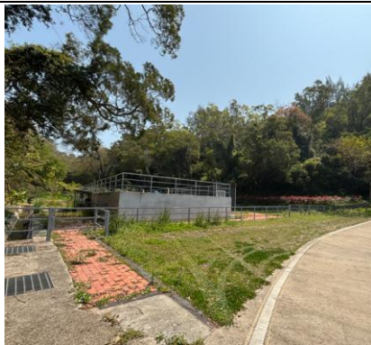
儲水沃上壩 MSL 場址環境清潔及除草
