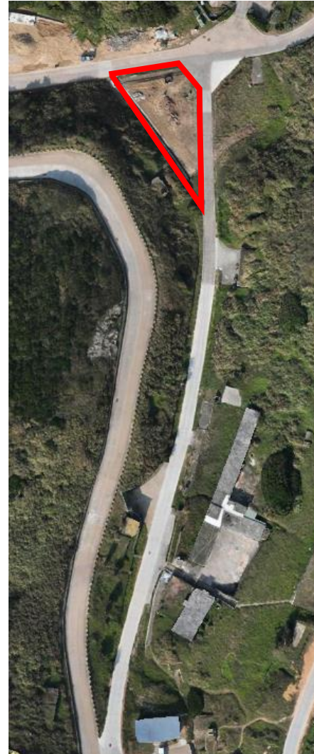
112.12空拍影像 (施工中)
