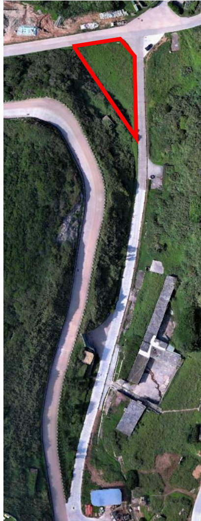
112.09空拍影像 (施工前)
