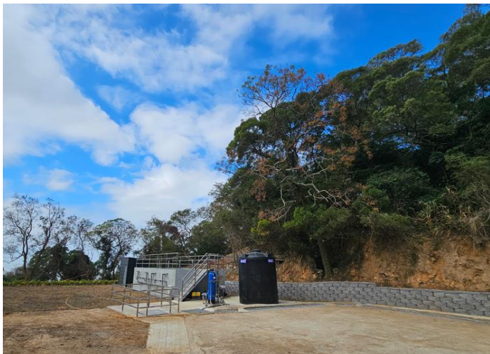
完工區域周邊樹林
