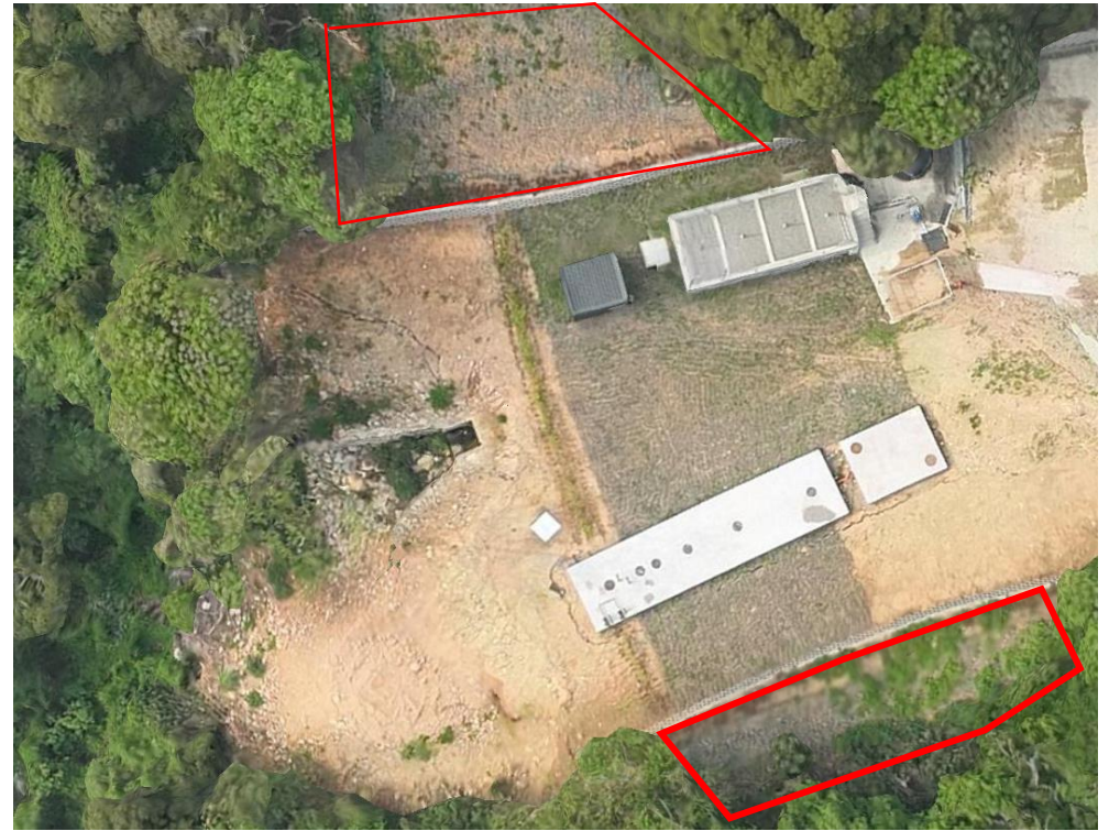
113.04空拍影像(施工後)
