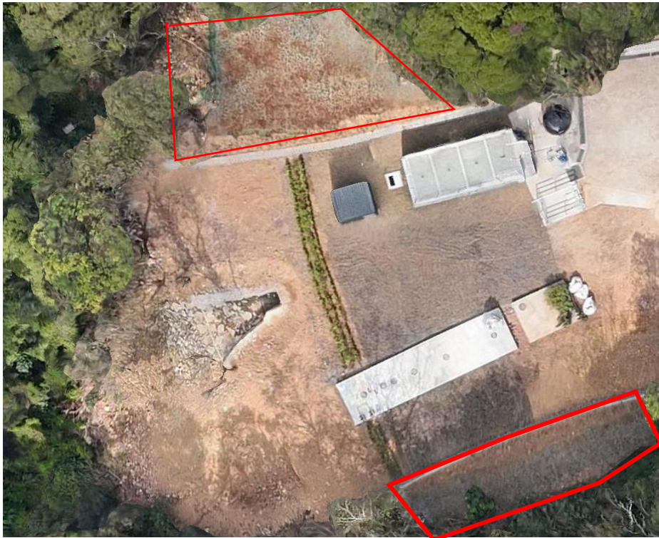
112.12空拍影像(施工中)
