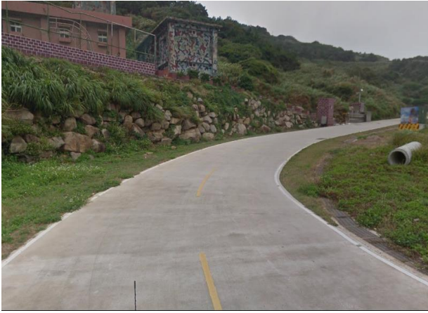
道路排水路現況
