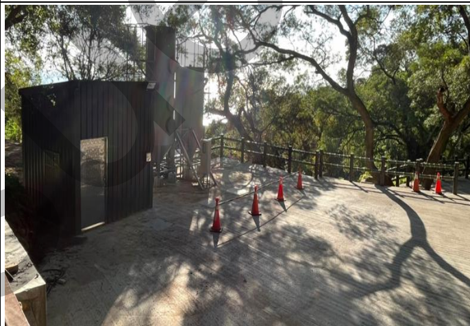
地面復原並增設安全欄杆
