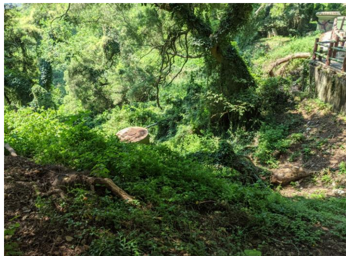
營舍前方邊坡
