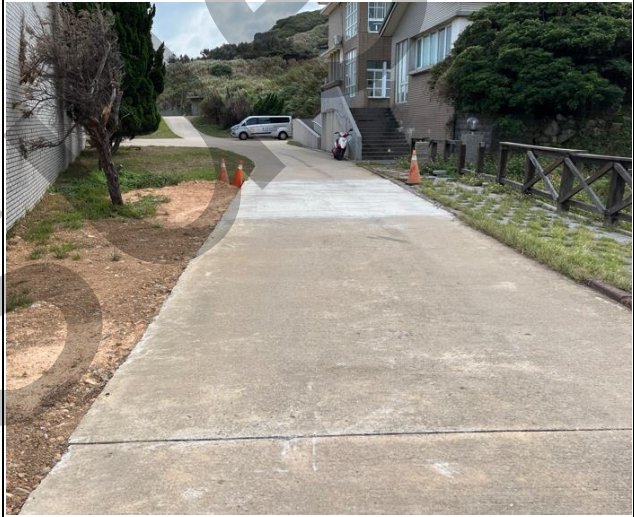
完成接管後道路復原
