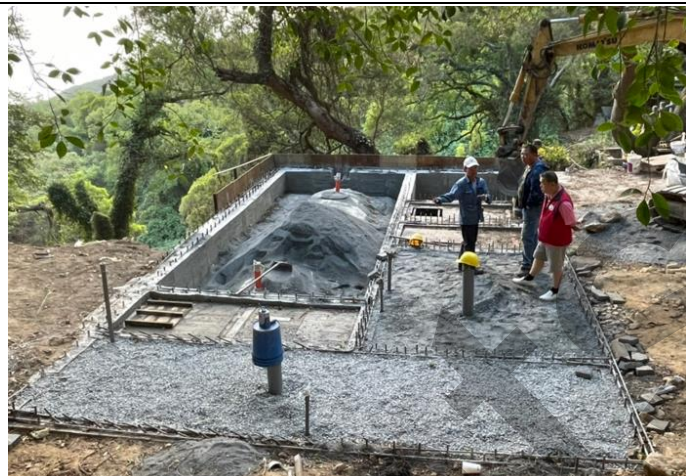
槽體及淨化槽施工
