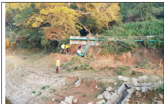
清除浮石及腐泥
