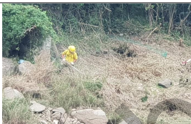
清除浮石及腐泥
