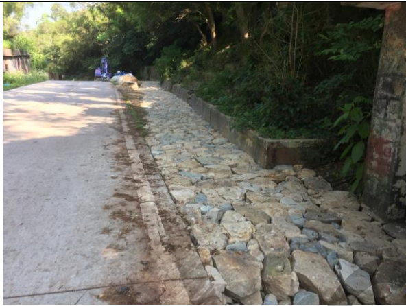
南 0K+073~0K+152 塊石溝完工
