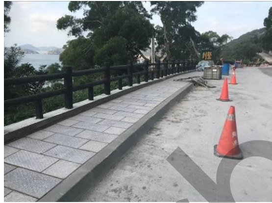
人行道花崗石鋪設施工後
