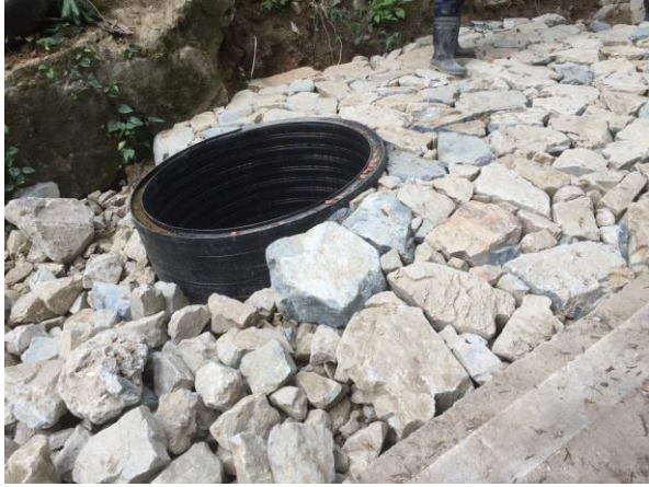
HDPE 陰井施工中
