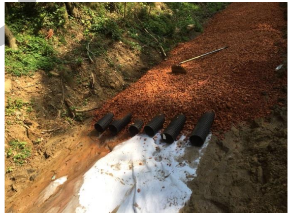
埋設 \Phi 20cm 透水管
