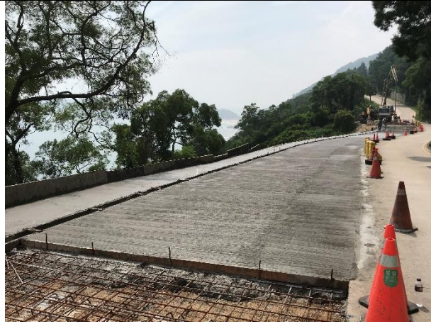
道路混凝土澆置施工後
