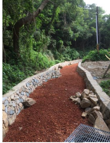
透水鋪面施工中
