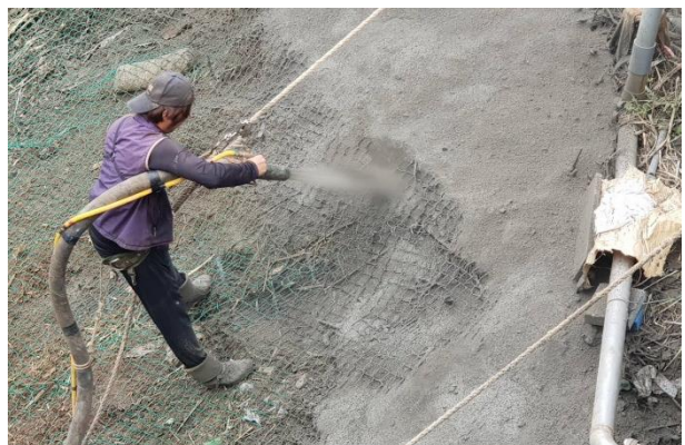
掛網噴凝土坡面
