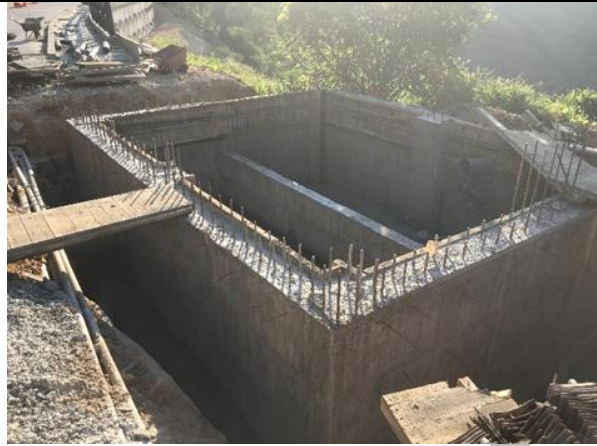
30T 雨水調節池施作
