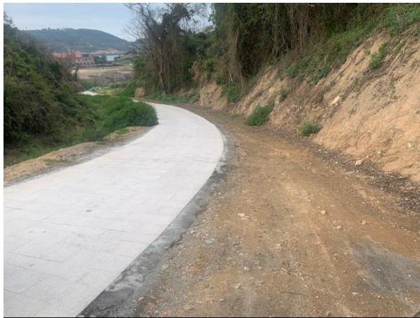
原珠螺集水區上游邊坡及道路
