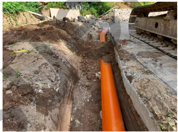
管線埋設施工
