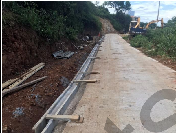
排水改善施工
