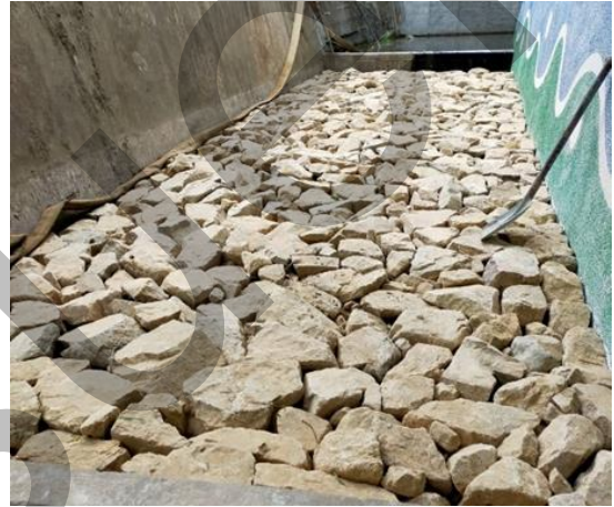
塊石透水鋪面鋪設
