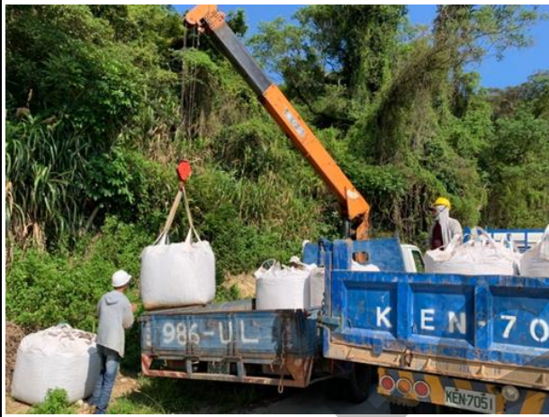
碎石進場鋪設
