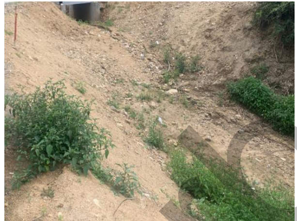
原珠螺集水區上游邊坡
