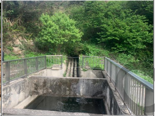
原津沙水庫上游水路
