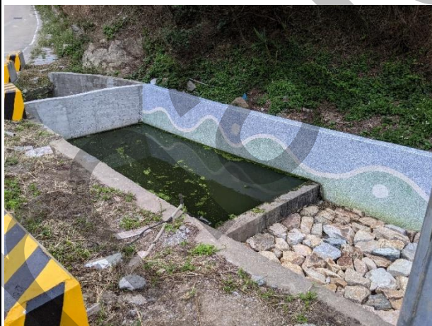
引水路整理、塊石透水鋪面成果
