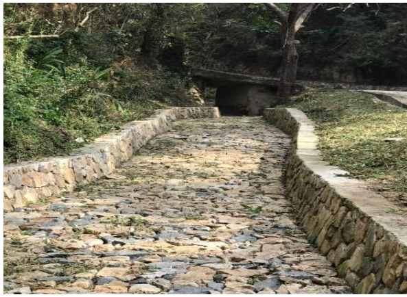
引水路整理、塊石透水鋪面
