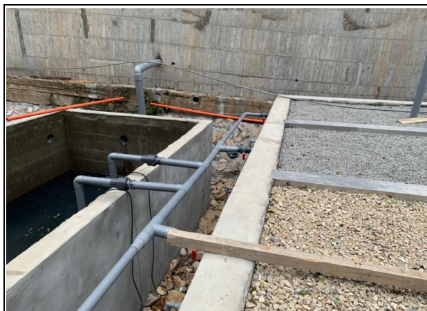
配水管線施作
