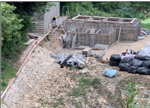
MSL 槽體施工
