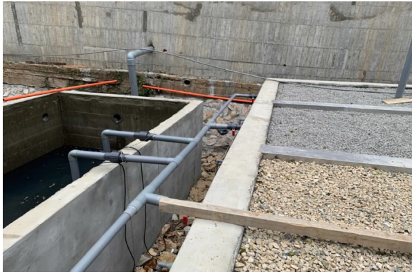
配水管線施作
