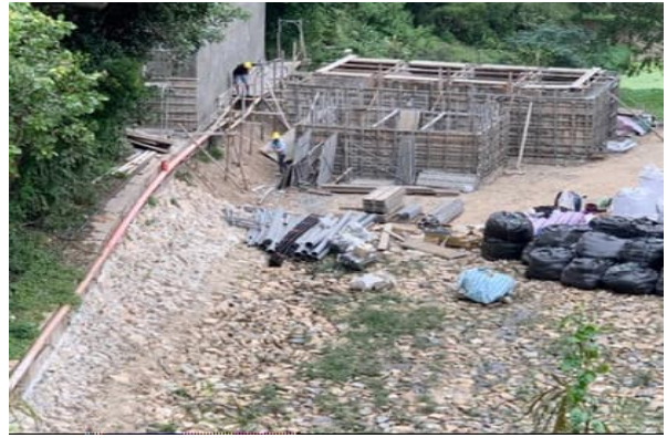
MSL槽體施工
