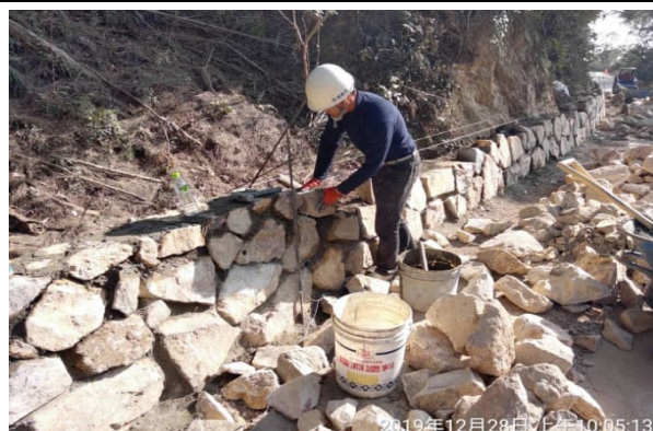
塊石矮牆施作
