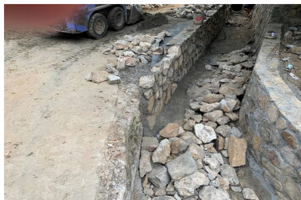
漿砌塊石牆及塊石鋪面
