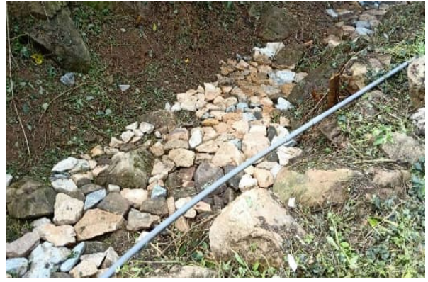
塊石透水鋪面
