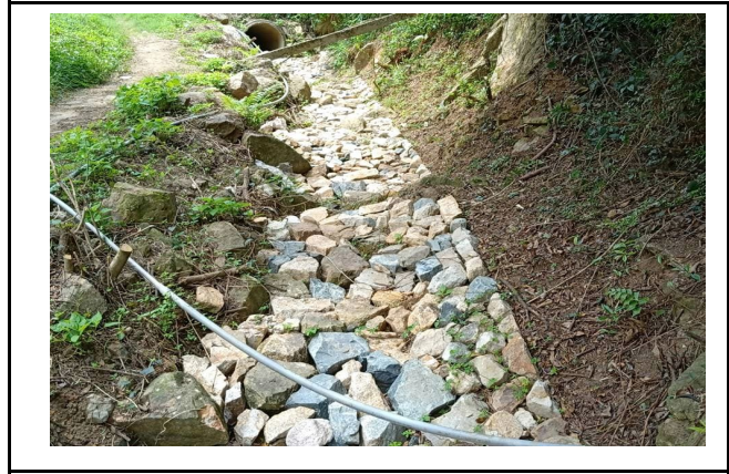
塊石透水鋪面
