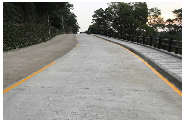
道路施作完成
