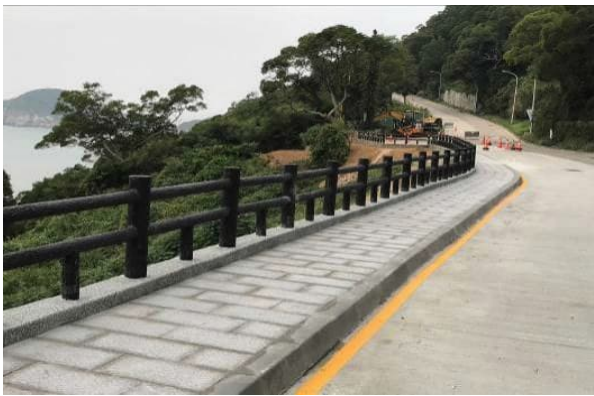
人行道施作完成
