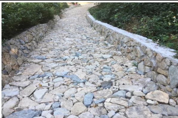
塊石透水鋪面
